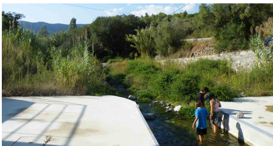
L'Associació Esportiva Baronia d'Escornalbou fa la inspecció d'un tram del barranc Reial a Riudecanyes. El tram presenta una qualitat dolenta del bosc de ribera als dos marges. A més de l'estació d'aforament de Duesaigües i la carretera que s'observa a la fotografia, hi ha ocupació de la zona de ribera per conreus i una estructura vegetal de baixa qualitat.
