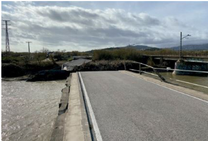
TRENCAMENT DEL PONT DE LA BV-6002
